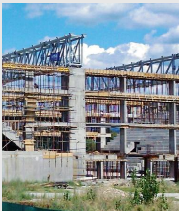
Sportska dvorana u Kraljevu - gradnja
