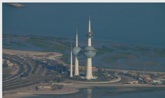
Rezervoari za vodu
