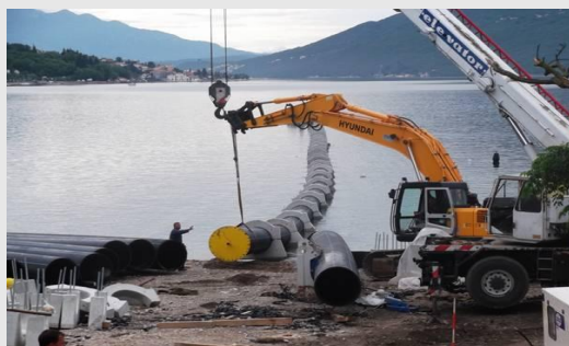
Izgradnja vodovoda i kanalizacije
